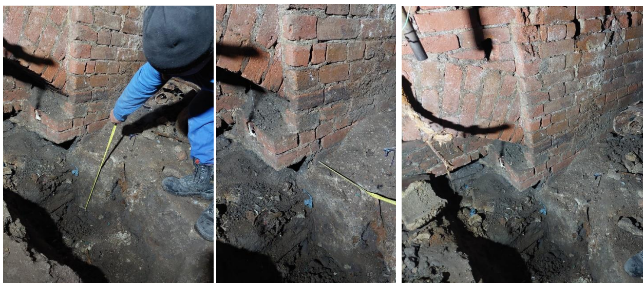
Figura 9. Fotografie din timpul realizării sondajului de dezvelire, D1
